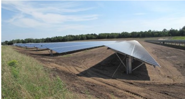
Solar array and Fond du Lac
