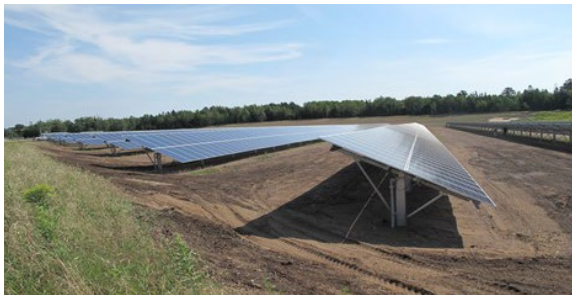
Solar array and Fond du Lac
